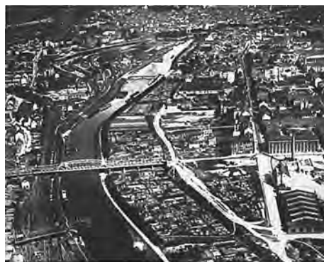
35. Der Saarbrücker Kohlenhafen
