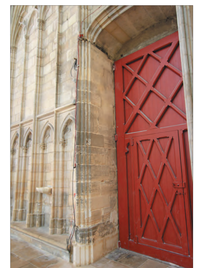
Abb. 07 Südquerhauswand innen. Das Wandprofil ist mit der Türleibung verzahnt. Foto: Fuhrmann 2010.
