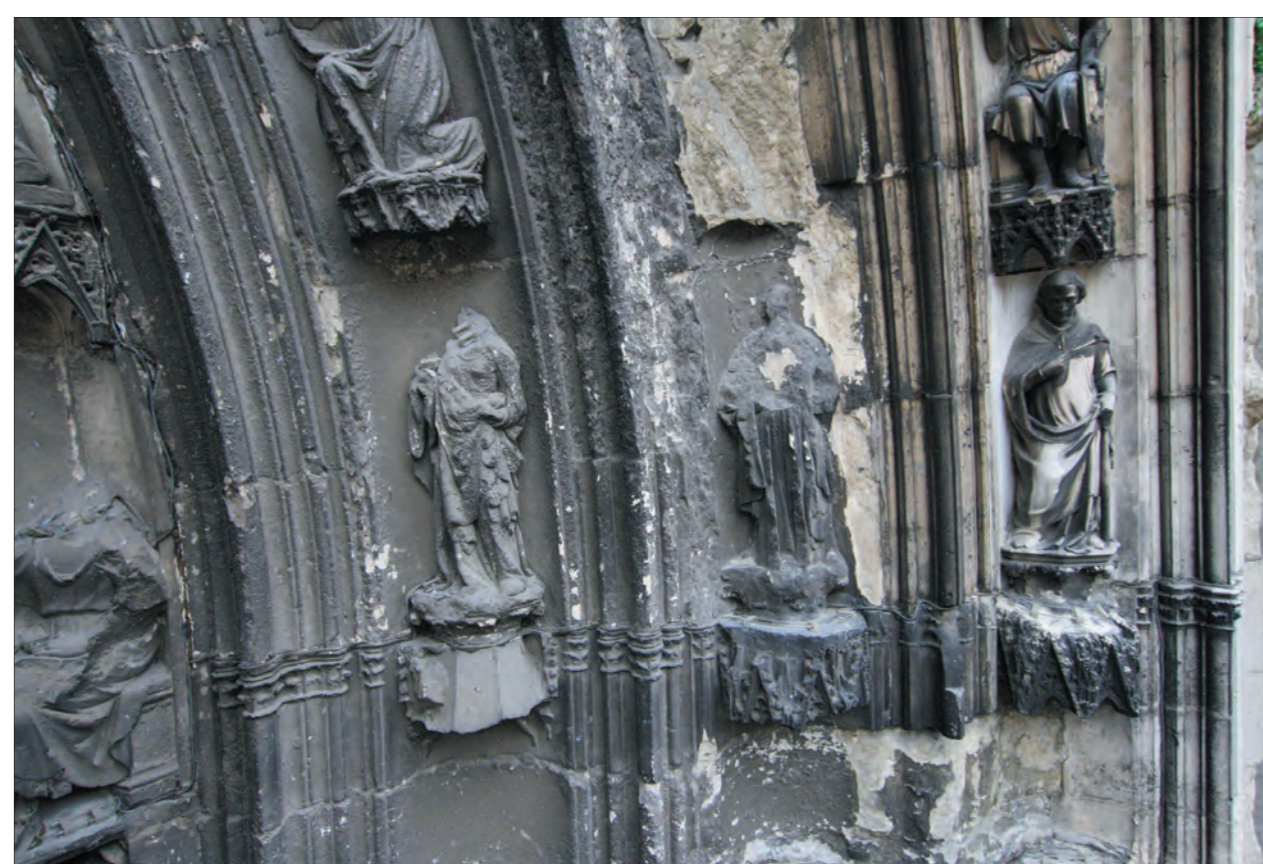
Abb. 02 Das rechte (östliche) Portalgewände des Südportals auf Kämpferhöhe und der Anschluss zum Tympanon. Zu erkennen sind der Steinversatz und die scharfkantigen Stoßfugen innerhalb der Profile. Foto: Breitling 2010.
