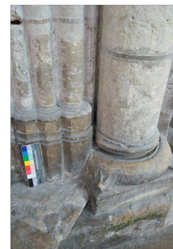
Abb. 06 Anschluss der Südwand an SW-Querhauspfeiler. Abgearbeitete Basis. Foto: Fuhrmann 2010.
