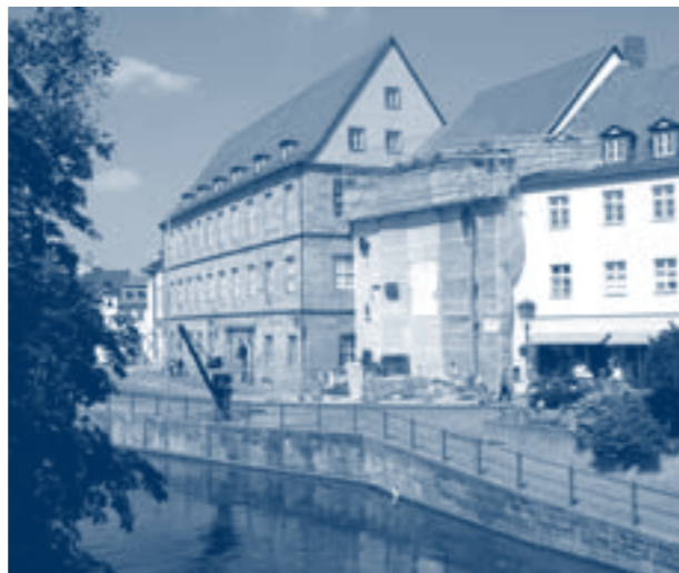
Baustelle „Am Kranen 10“
