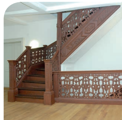
Der Sanierungsfokus lag auf der barocken Treppe.
